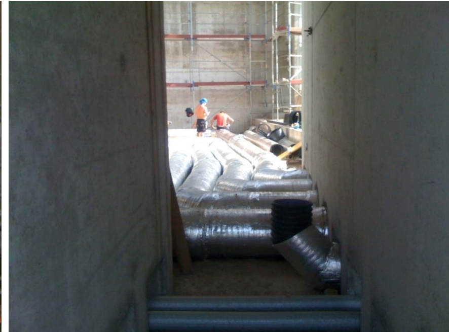
■ Lüftungsverteilungsrohre im Unterbau der Kletterhalle
