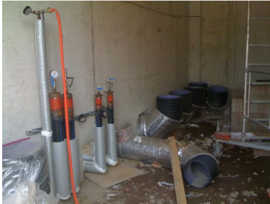
■ Lüftungsrohre in der Lüftungszentrale der Kletterhalle
